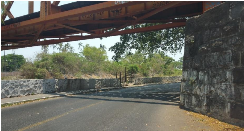
Figura 8. Estado actual de la calle 18 de Marzo. Fuente: IPCO (2015).
