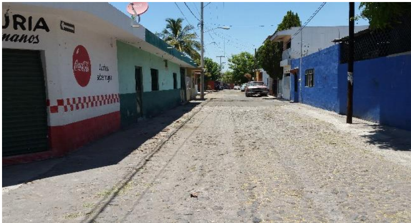
Figura 7. Estado actual de la calle Manuel Ruíz. Fuente: IPCO (2015).
