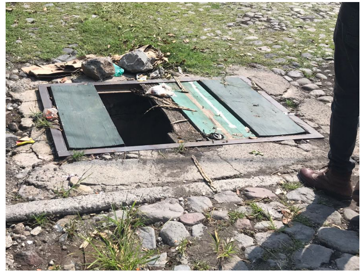
Imagen de Afectación ALCANTARILLA PLUVIAL SIN TAPA. FOTO ACTUAL / AGOSTO 2022.
