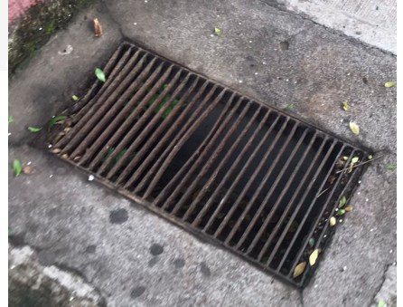
TAPA EN REGISTRO PLUVIAL EN ANDADOR JUAN PINZON
