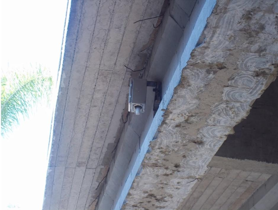
**Figura 1.41** Vista del proceso de instalación del sensor de nivel en el río Colima. Octubre de 2011.
