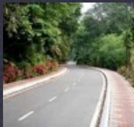
Paso desnivel por Río Colima
