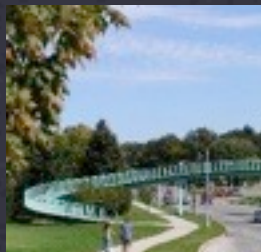
Puente peatonal accesible
