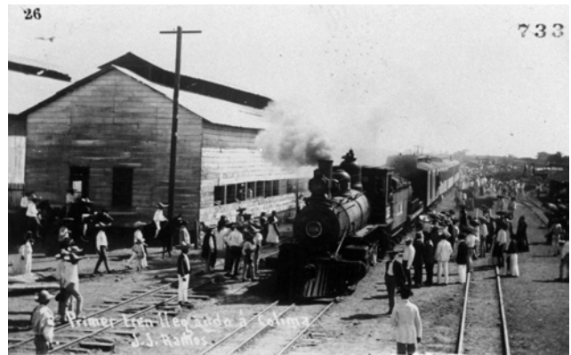
Primera estación del Ferrocarril
