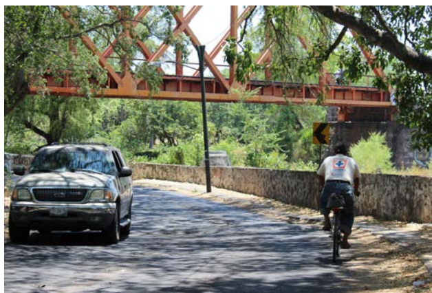
Puente Ferroviario en el ingreso a la colonia el Tivoli, por la calle 18 de marzo. Acervo fotográfico IPCO 2014
